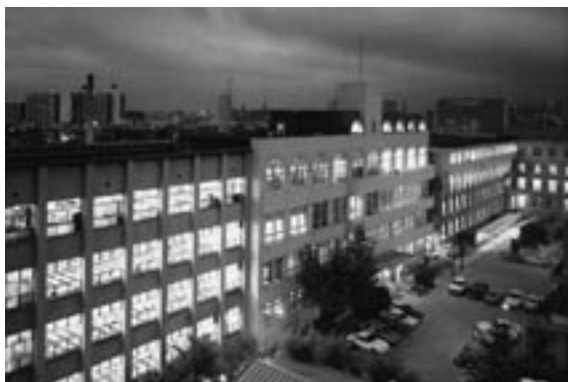
13 天六学舎と図書館天六分館 平成6年3月まで中央と左の建物の4階に分館があった。
