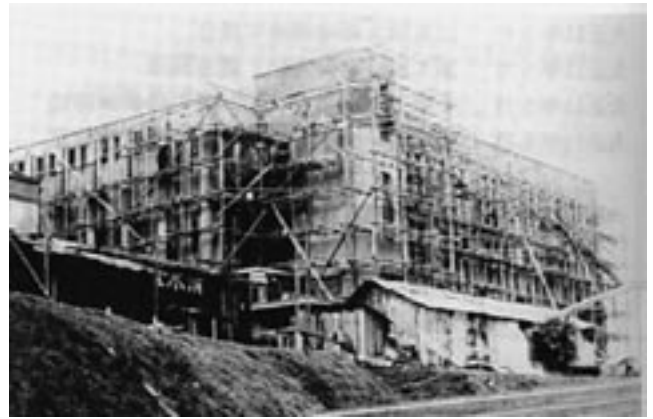
4 千里山本館建築の様子（昭和2年）
