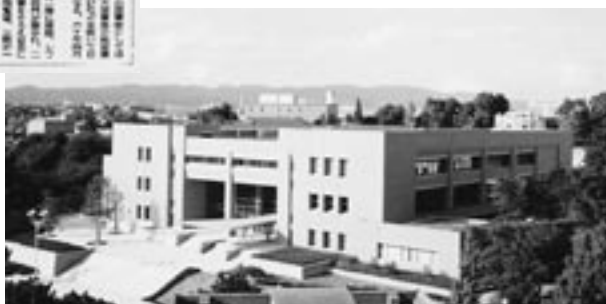
18 竣工当時の総合図書館（昭和59年）
